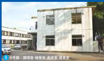
I 6号館／調理室・被服室・美術室・音楽室
